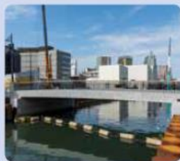
橋梁架け替え工事 (東武谷内田建設)
