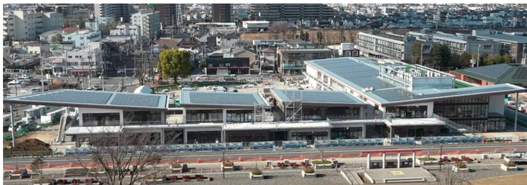
△屋根に配置したソーラーパネル
