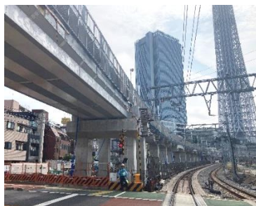
△とうきょうスカイツリー駅付近 工事状況
