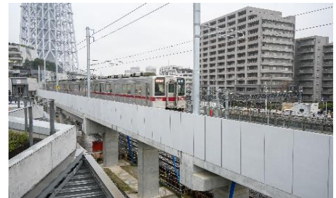
△とうきょうスカイツリー駅付近 工事状況
