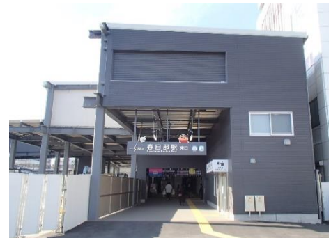
△春日部駅東口仮駅舎
