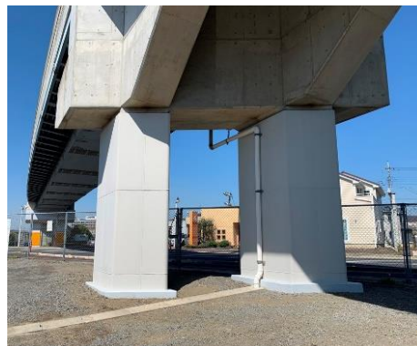
△高架橋耐震補強
