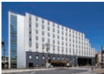
東京曳舟病院
