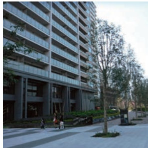
外構植栽工事（東武緑地）
