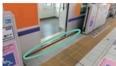
ホーム先端部の改修
