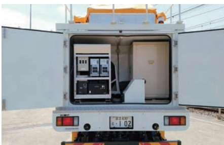
電気検測車に搭載された機器
