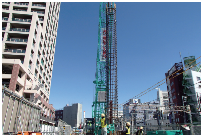
② 高架橋の基礎杭を作っています。写真はクレーンで鉄筋を建込んでいる状況です
