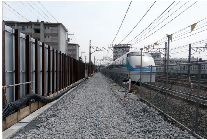
① 上り急行線をUR団地側に移動するために線路を作っています。まず、線路下になる地盤を改良し(左写真)その後線路砕石を敷きました(右写真)。今後、PC枕木を並べレールを敷いていきます。
