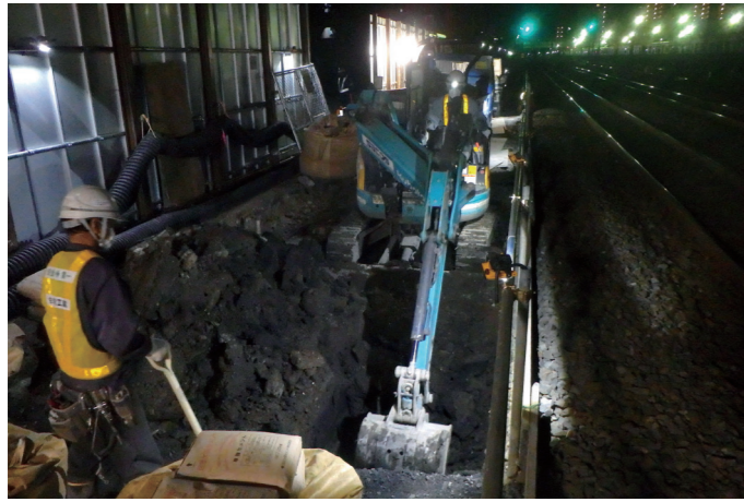
① 上り急行線をUR団地側に移動するために線路を作っています。まず、線路下になる地盤を改良し(左写真)その後線路砕石を敷きました(右写真)。今後、PC枕木を並べレールを敷いていきます。
