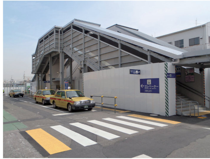
① 階段を仮設階段に切り替えました。併せてタクシー乗り場を階段脇に変更いたしました。
