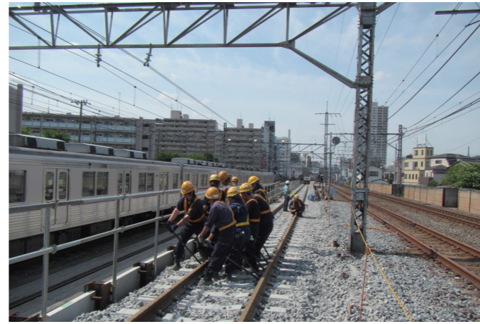
④ 下り緩行線を東側に移動するため、昨年度撤去した引上線の跡地に盛土をし、線路を作っています。人力で線路を正しい位置に作っていきます(左写真)。線路砕石は夜間に運搬・荷卸しています(右写真)。
