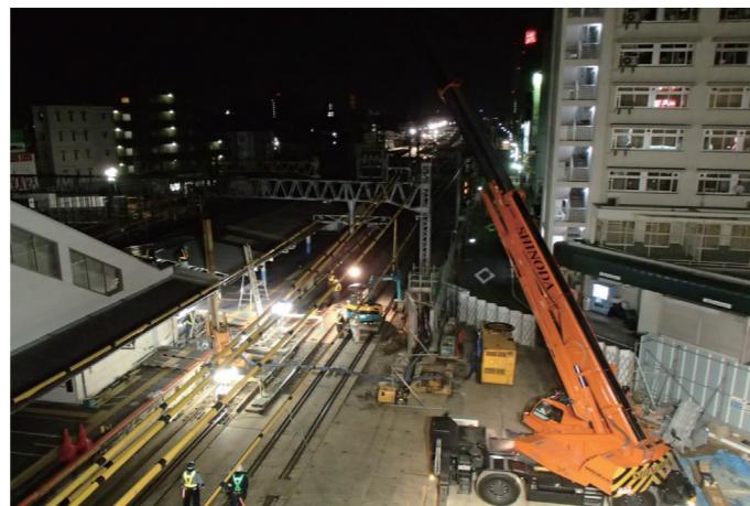
③ 駅付近では夜間工事にて仮設の地下通路を作るための準備工事を行っています。
