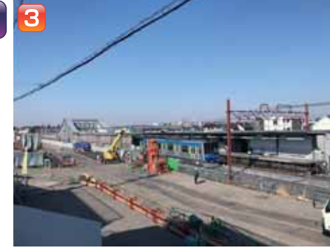
愛宕駅付近では、旧駅舎・ホームの撤去が完了し、高架橋の基礎杭工事に着手しました。
