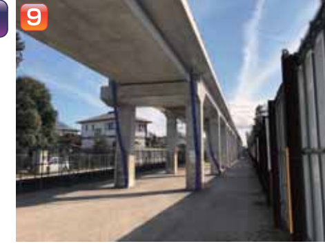
野田市から梅郷方にかけて、高架橋工事が進んでいます。
