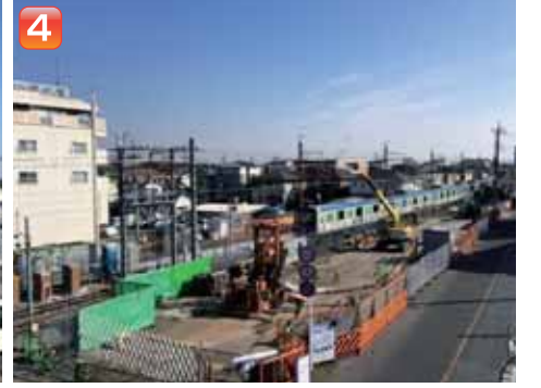
愛宕駅付近では、旧駅舎・ホームの撤去が完了し、高架橋の基礎杭工事に着手しました。
