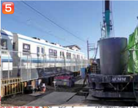
愛宕駅～野田市駅間では高架橋の基礎杭・基礎工事を 実施しています。
