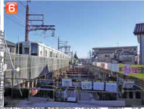
愛宕駅～野田市駅間では高架橋の基礎杭・基礎工事を 実施しています。
