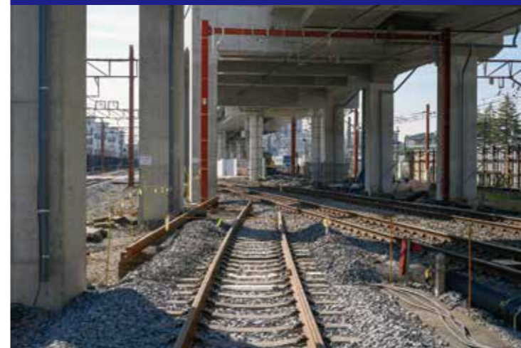
②東京メトロ入出庫線交差部
