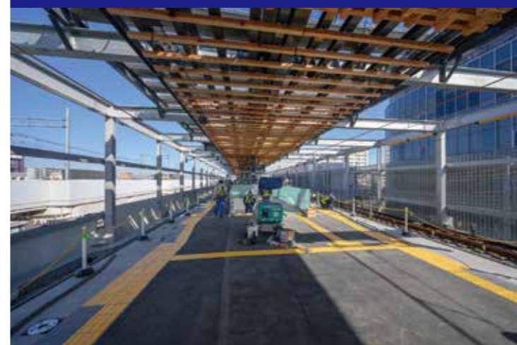
⑤高架上の新ホーム
