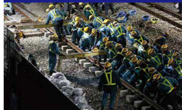
線路切替状況
