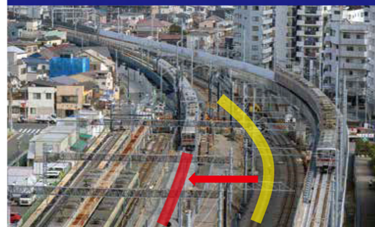
切替工事後の状況(曳舟方)
