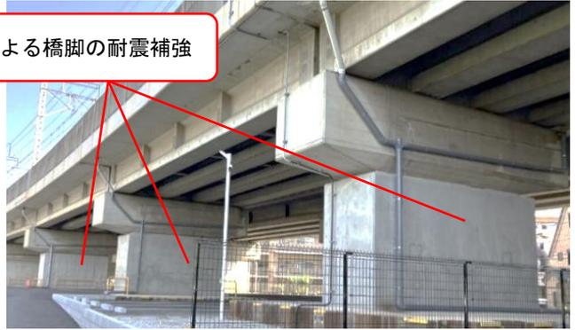
△高架橋柱等耐震補強の状況（小菅～五反野駅間）
