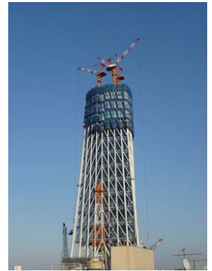
建設中の東京スカイツリー(2009年11月現在)
