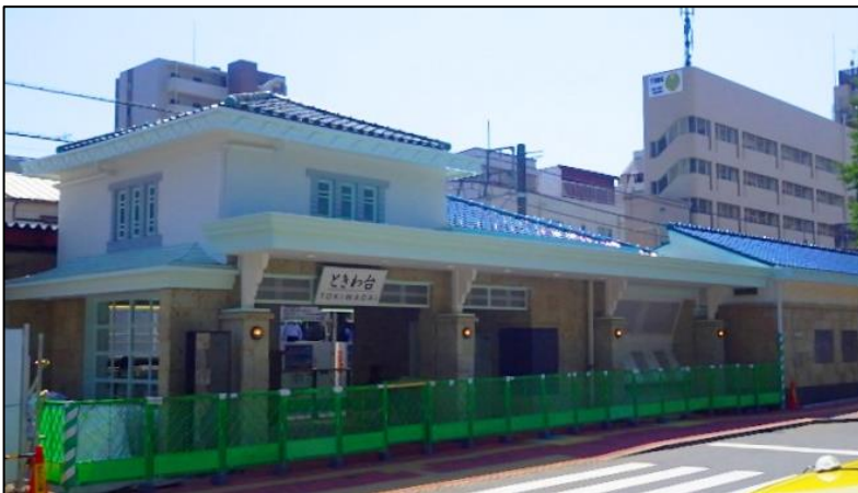
△ときわ台駅 駅舎（リニューアル工事中）
