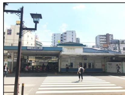
△工事着手前の駅舎外観
