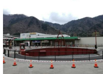
△鬼怒川温泉駅構内の転車台
