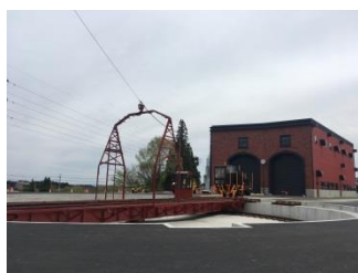
△下今市駅構内の転車台
