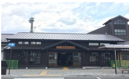
△下今市駅のリニューアル（工事中）
