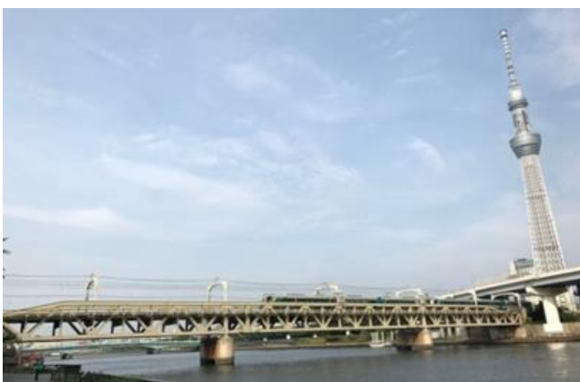
△隅田川橋梁（隅田公園より）
