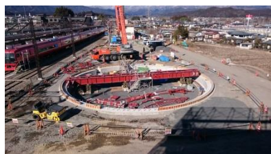
△下今市駅構内に整備中の転車台
