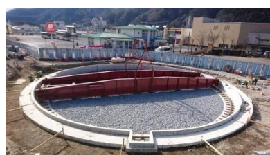
△鬼怒川温泉駅構内に整備中の転車台
