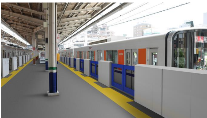
△ 和光市駅東上線側ホーム 可動式ホーム柵設置イメージ
