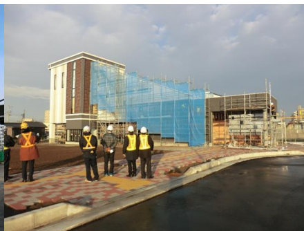
△幸手駅西口状況（H31.2.6撮影）
