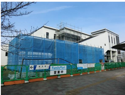
△幸手駅東口状況（H31.2.7撮影）
