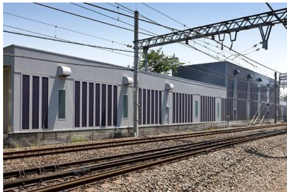
ふじみ野変電所 (外壁一体型太陽光パネル)
