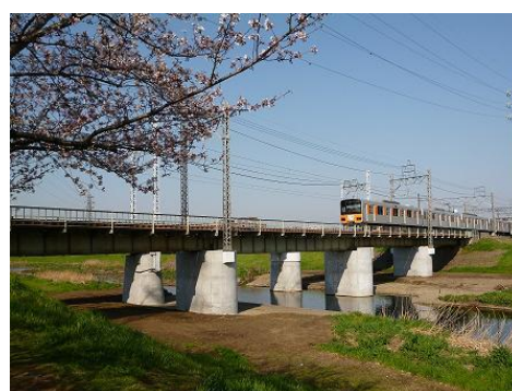
橋梁改修工事（橋脚耐震補強）
