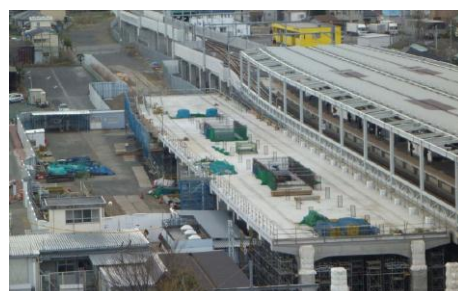
伊勢崎駅付近高架化工事
