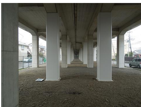
高架橋柱耐震補強工事
