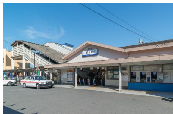
△新河岸駅 旧駅舎
