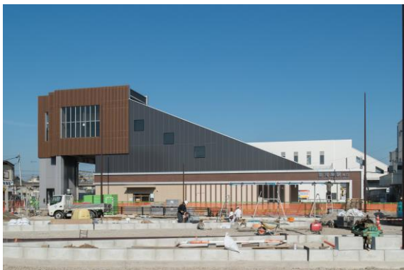
△新河岸駅西口 新駅舎（外観）
