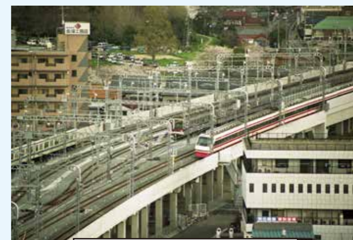
北越谷駅付近(平成11年 高架化)
