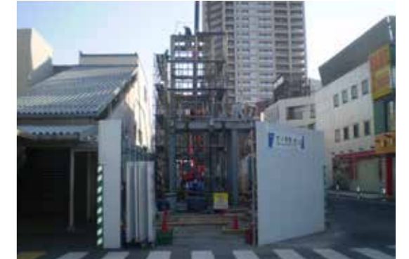
高架橋を作るために支障する西口階段を移設します。写真は谷塚方階段の鉄骨を建てている様子です。
