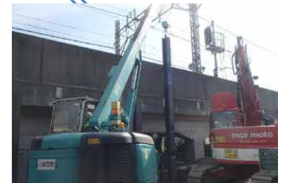
引上線があった場所に下り線の線路を敷くための路盤を作ります。写真は、盛土の土留杭を設置している様子です。
