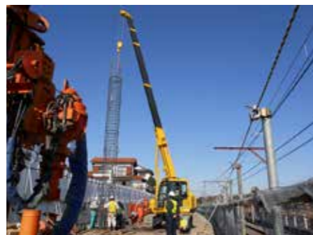
高架橋杭鉄筋の建込
