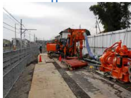
TBH機による高架橋基礎杭の掘削
