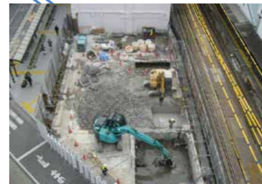
駅ビルの一部を壊して地下通路の出入口を作ります。
