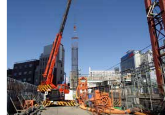
高架橋の基礎杭を作っています。写真は孔を掘ったところに鉄筋を建て込んでいる様子です。このあとコンクリートを流し込んで基礎杭が完成します。
