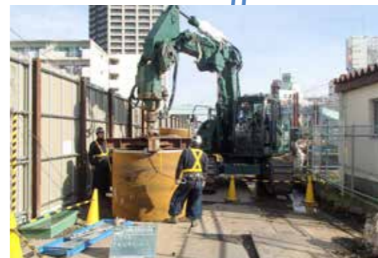
高架橋の基礎杭を作っています。写真は孔を掘るときに周りの土が崩れないよう鋼管を設置している様子です。
