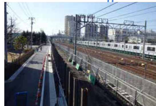
高架橋を作る場所を確保するために線路を移設します。写真は道路を移設し、跡地に線路を移設するための準備工事の様子です。
