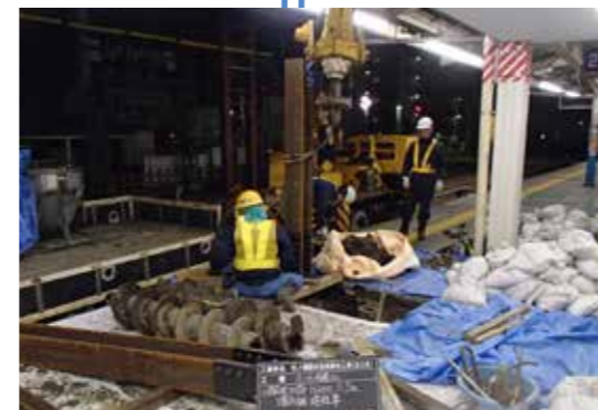
ホーム上では、夜間に地下通路を作るための準備作業を行っています。
