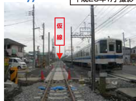
野田市～梅郷間仮線工事中
