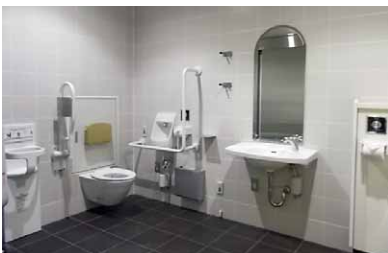
新古河駅多機能トイレ
