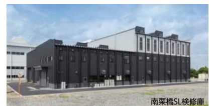
南栗橋SL検修庫
