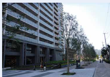
外構植栽工事 (東武緑地)
