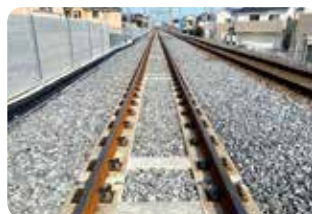
バラストラダー軌道
