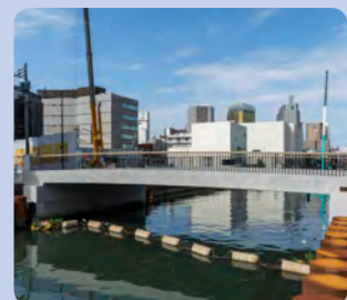
橋梁架け替え工事 (東武谷内田建設)
