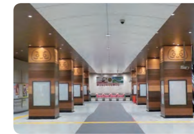
北越谷駅コンコース照明器具
