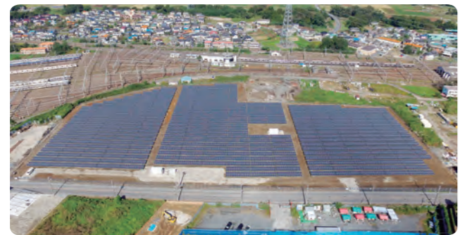
東武森林公園太陽光発電所
