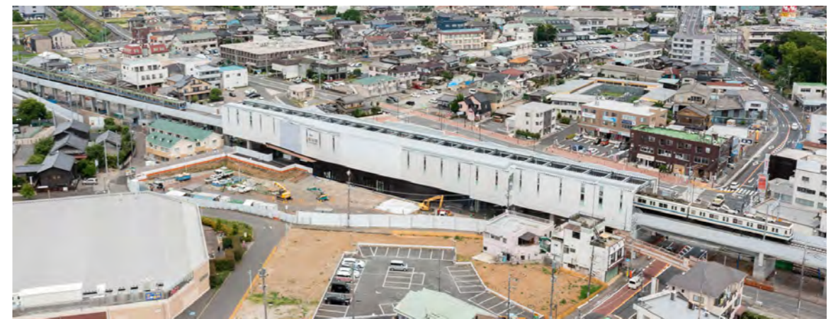
高架化した愛宕駅付近の様子
