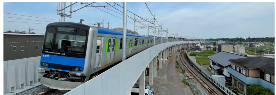
愛宕駅付近の高架橋
