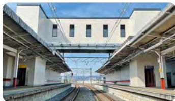
エレベーター（新桐生駅）
