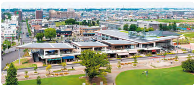
商業施設「TOBU icourt/トーブ イコート」(埼玉県草加市)
