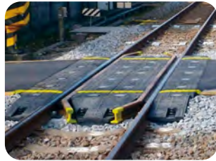
再生プラスチック製の踏切板
