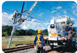
災害復旧作業
