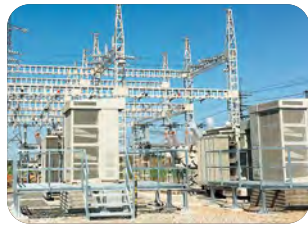
設備機器のかさ上げ
