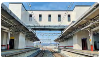
エレベーター（新桐生駅）
