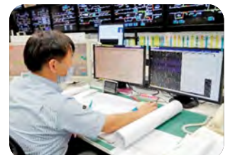
運転指令による避難列車のシステム入力作業
