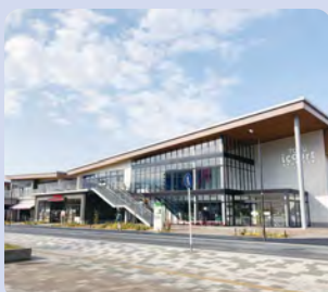
商業施設(TOBU icourt)建設工事 (東武谷内田建設)
