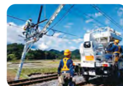
災害復旧作業
