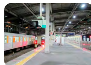
高架区間に避難した車両
