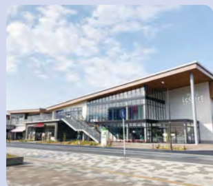
商業施設(TOBU icourt)建設工事 (東武谷内田建設)
