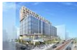
(仮称)東武ホテル川越駅西口駅前
