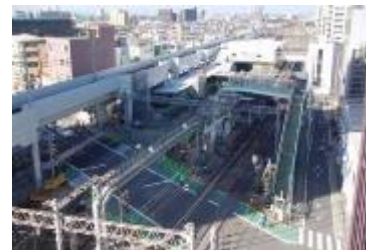
竹ノ塚駅付近高架化工事
