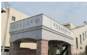
橋上駅舎化された運河駅
