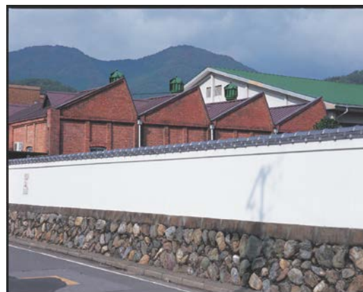
桐生市 のこぎり屋根の 織物工場
