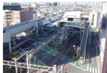
竹ノ塚駅付近高架化工事
