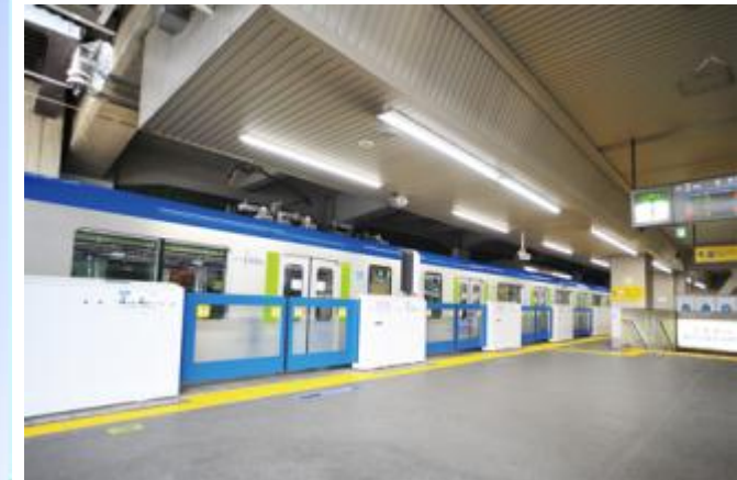
船橋駅ホームドア(可動式ホーム柵)
