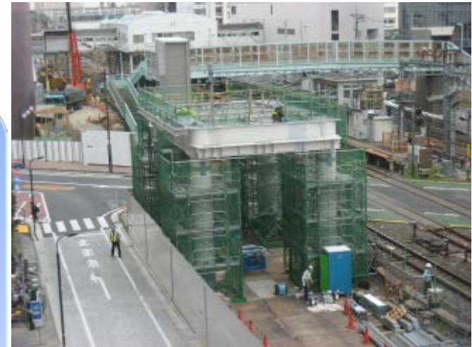
竹ノ塚駅付近連続立体交差化事業 (高架橋建設)
