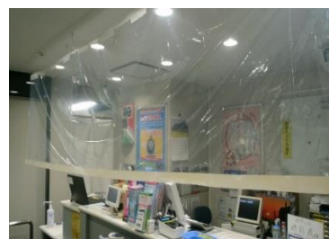
【ビニールカーテン】
