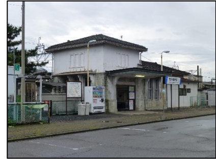
△工事着手前の駅舎外観
