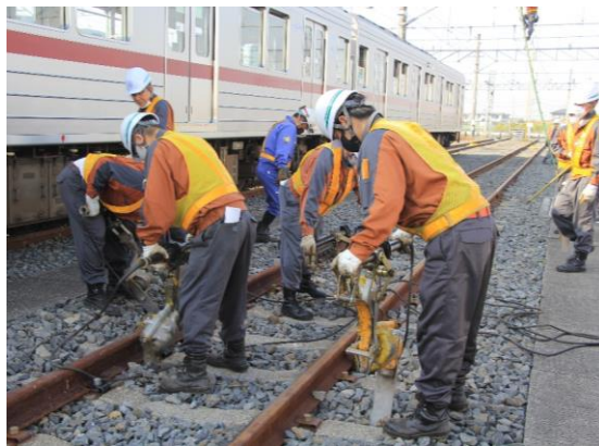
線路復旧作業
