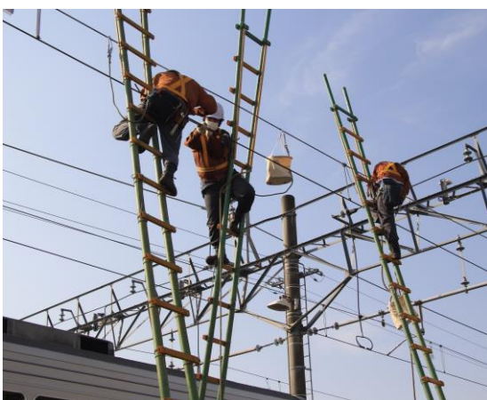
架線復旧作業
