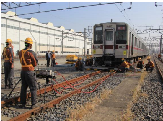
脱線復旧作業
