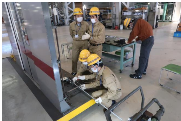
△「空気配管」組み立ての様子
