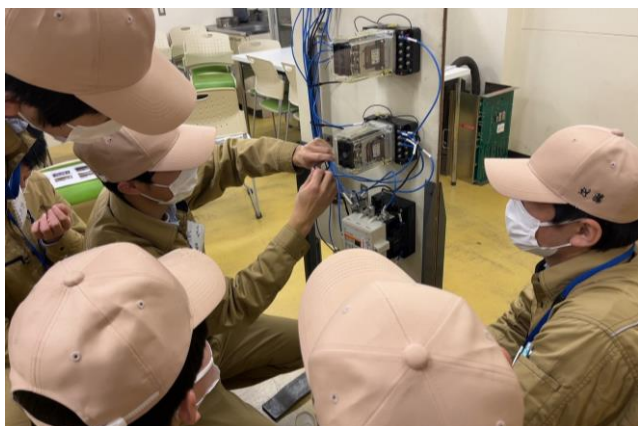
△「電気配線」組み立ての様子
