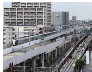
竹ノ塚駅付近の工事状況
