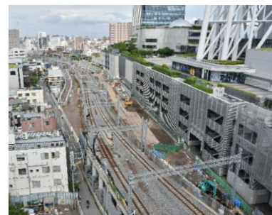
とうきょうスカイツリー駅付近の工事状況
