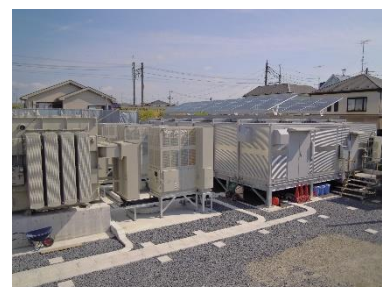
△嵩上げ後の変電所
