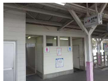
旅客トイレ改修前
