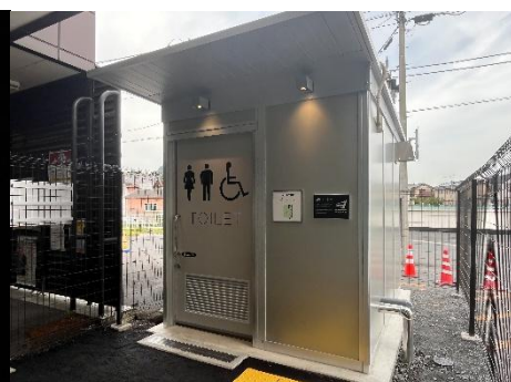
葛生駅旅客トイレ（改修後）
