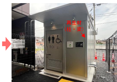
葛生駅旅客トイレ（改修後）
