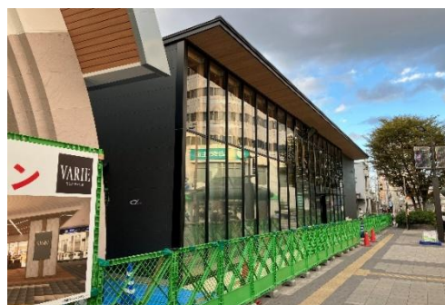
△「VARIE 2」側駅前 新棟（新設／2025年10月27日現在）
