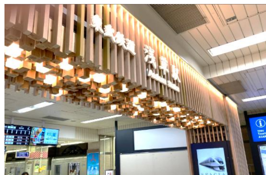
△間伐材を使用した駅舎リニューアル（浅草駅）
