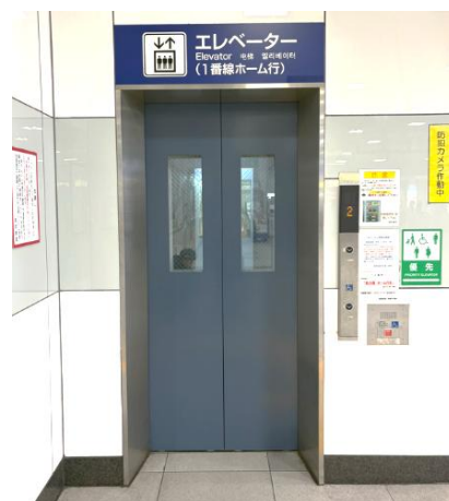
△エレベーター更新（新鎌ヶ谷駅）
