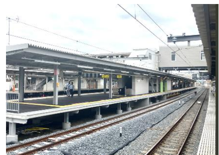
△春日部駅付近高架化 下り線仮ホーム 切替え後
