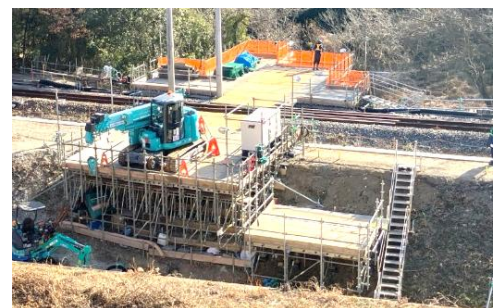
△法面改修工事 (武蔵嵐山～小川町駅間)
