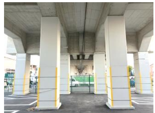
△高架橋柱等耐震補強工事 (獨協大学前～新田駅間)
