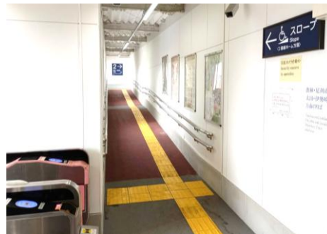
△スロープ整備（茂林寺前駅）
