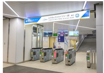
△とうきょうスカイツリー駅付近高架化 曳舟側駅舎 供用開始
