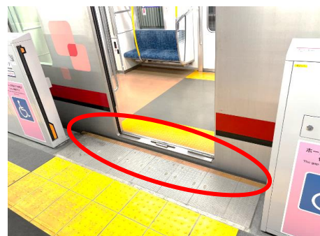
△ホームと車両乗降口の段差・隙間縮小（西新井駅）
