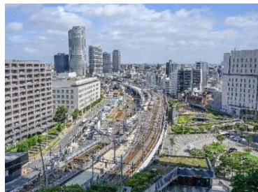
〈連続立体交差事業の様子〉
