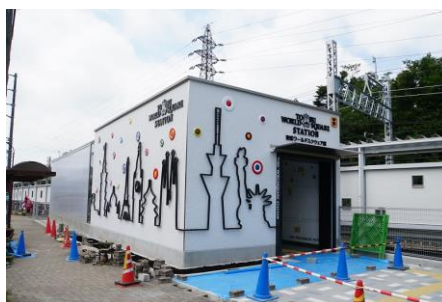
△ 新駅「東武ワールドスクウェア」（建設中）
