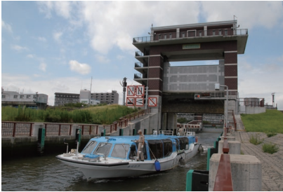
荒川ロックゲート
