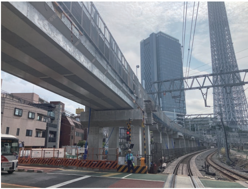
△とうきょうスカイツリー駅付近 高架橋
