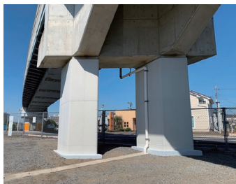
△高架橋耐震補強
