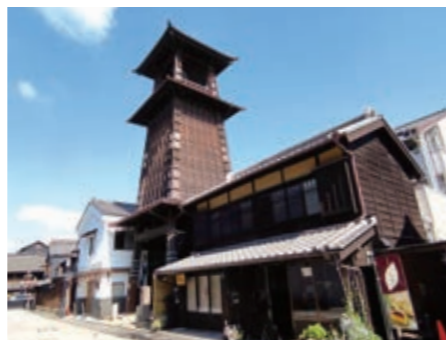
木造三層構造で高さ16.2mの「時の鐘」。現在建っているのは4代目。
