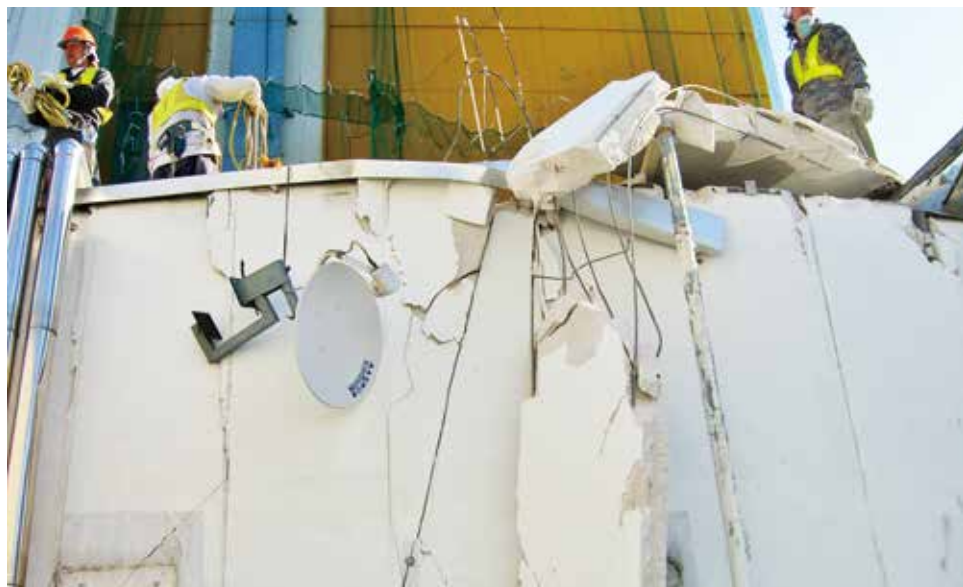
曳舟駅線路脇のビルの外壁が崩れ落ちた様子(左・中) (提供：東武谷内田建設)
